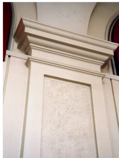
Detalle de un revestimiento de columna de fachada en Acrystal Prima - Panel laminado con fibra 200-4D de aproximadamente 7 mm de grosor
