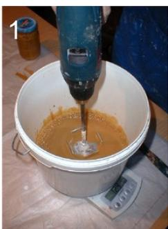
Utiliser un mélangeur à lames coupantes à une vitesse supérieure à 700 tours / mn afin de créer un tourbillon et de fracturer les grumeaux. Respecter scrupuleusement la chronologie des opérations.
